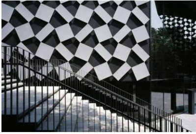
Detalhe do revestimento da fachada.
