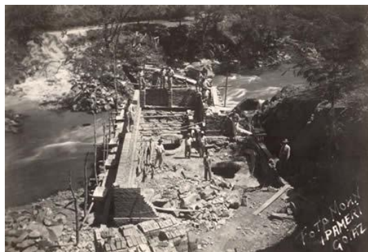
Figura 4: Construção da Barragem da Usina Major Aristides Lopes, 1946.
